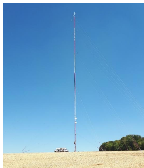
Figure 2 : Mât de mesure du parc éolien de Demange-aux-Eaux
