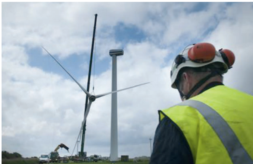
FIGURE 65 : INSTALLATION DES PALES LORS DU RENOUVELLEMENT DU PARC DE KLIM FJORDHOLME Source : VATTENFALL
